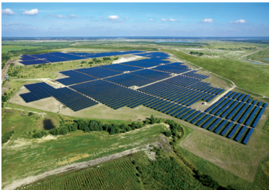
Solaranlage in Senftenberg/Brandenburg; Foto: Phoenix Solar AG
