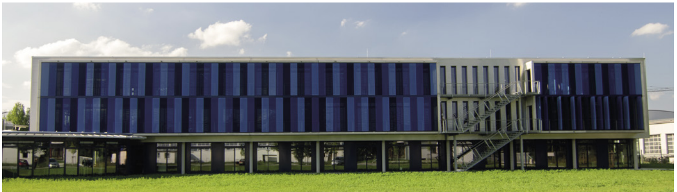
Hauptsitz in Thierhaupten: Die Firmenzentrale der Aumüller Aumatic GmbH nahe Augsburg
