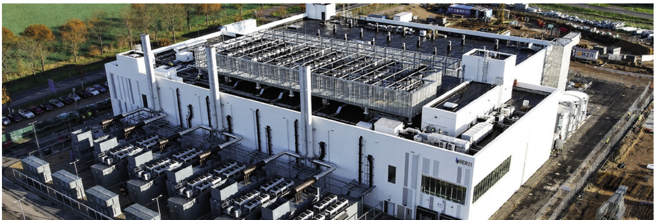
Komplexe Projekte aus einer Hand: Beim Rechenzentrum „BER21“ kümmert sich Arikon um die Stromversorgung.
