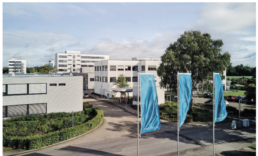
Der Hauptsitz in Wedel geht auf ein Werk der AEG aus den 1960er-Jahren zurück. Foto: © Vincorion
