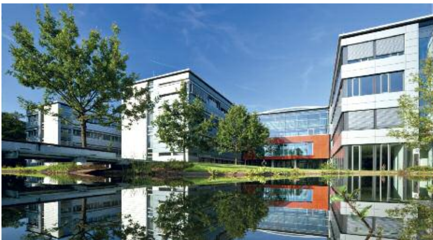
Die Firmenzentrale der Goldbeck-Gruppe: Das 1969 gegründete Stahlbauunternehmen entwickelte viele neue Lösungen, die heute Standard sind.
