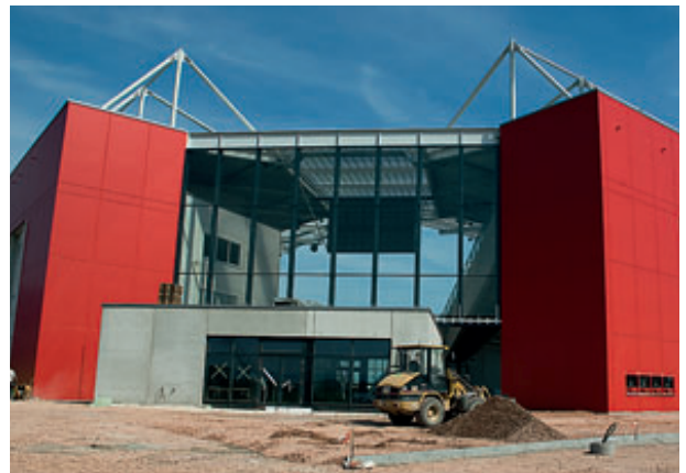
Die Coface-Arena des Fußballclubs Mainz 05 – errichtet mit Baustoffen der Fixit Gruppe
